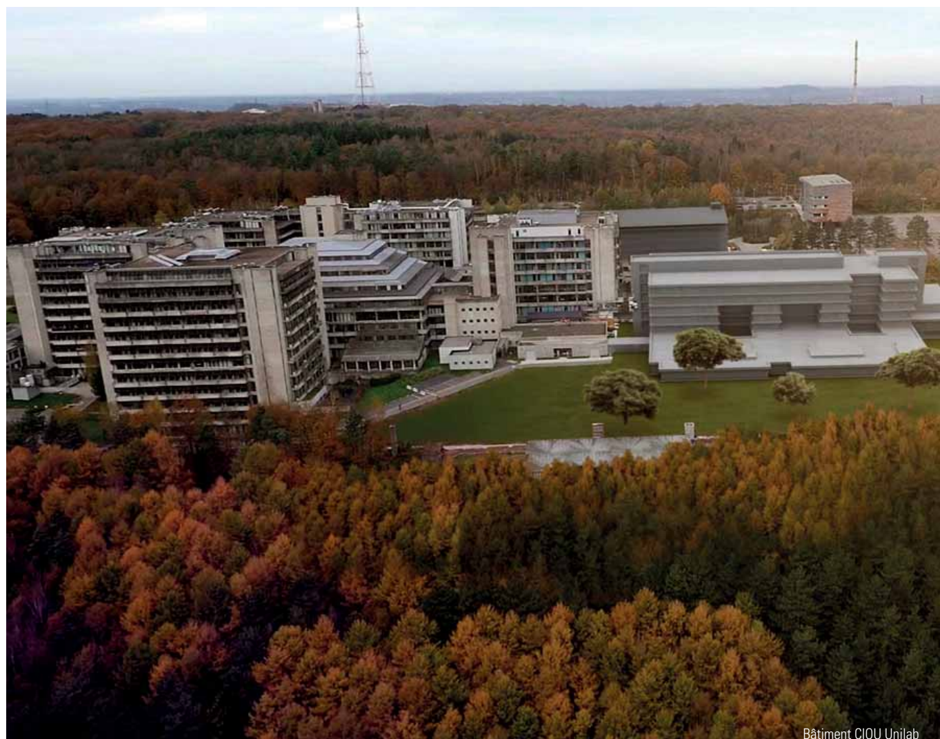
Bâtiment CIOU Unilab
